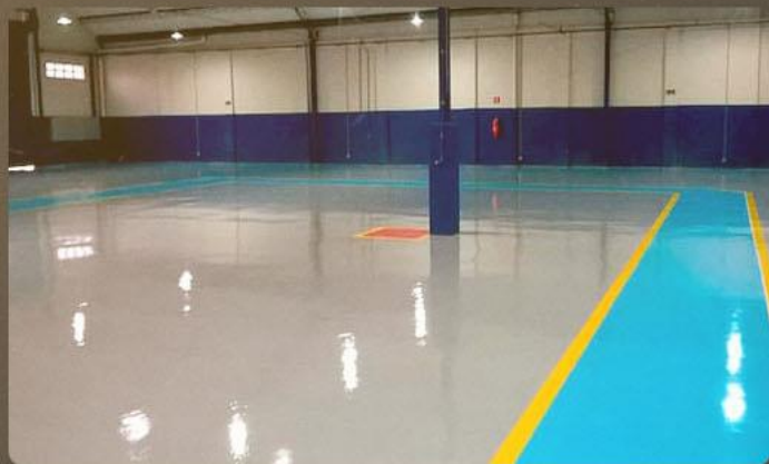
Piso com resina de epox.
